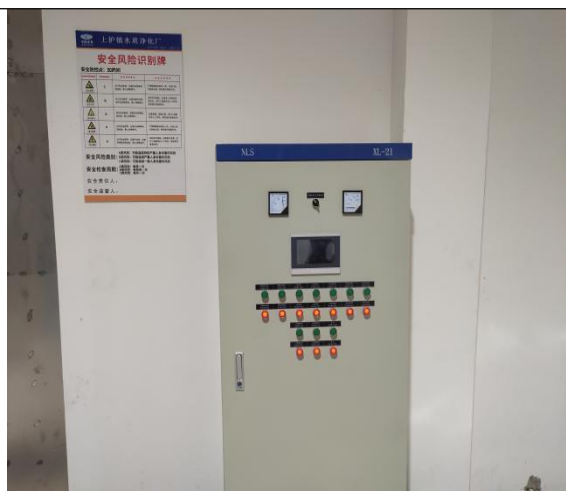
螺杆泵、PAC、PVC 等控制开关处
