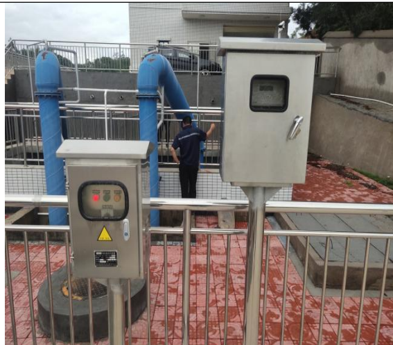
计量槽控制开关、流量计
